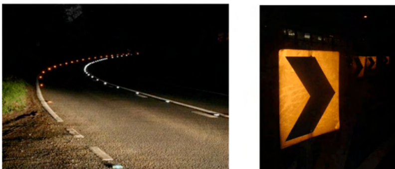
Figura 2: Sinalização horizontal (dispositivos auxiliares no solo) e vertical (semáforos e placas), com falta de acostamentos.
