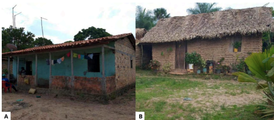
Figura 09. Condição das casas encontradas nas comunidades remanescentes de quilombos de Bequimão/MA: Casas de alvenaria (A) e casas de taipa (B).
