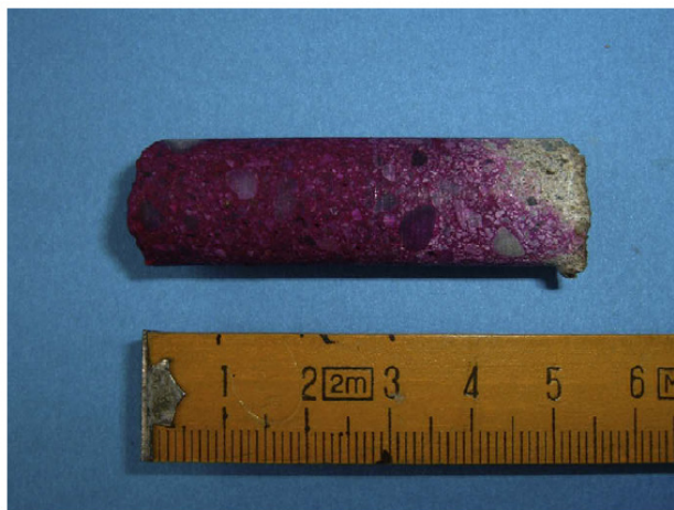
Figura 6. Teste de fenolftaleína em um núcleo de concreto retirado da coluna após o tratamento preliminar (Bertolini et al. (2008)).
