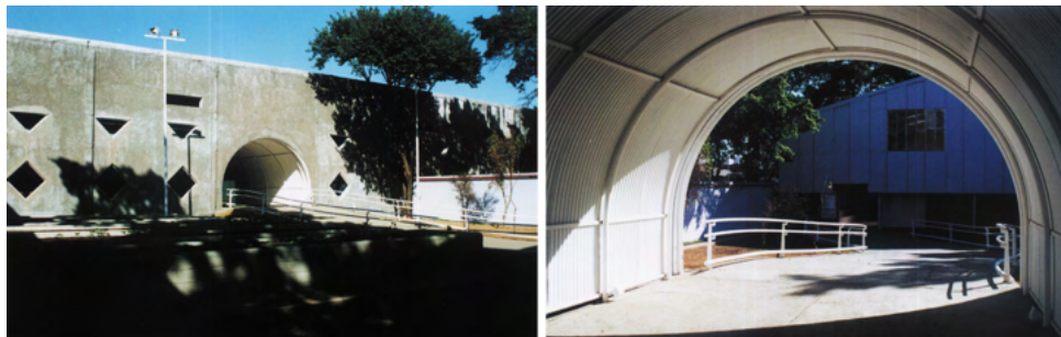
Figura 4: Oficina Boraceia. Face e túnel de acesso.
