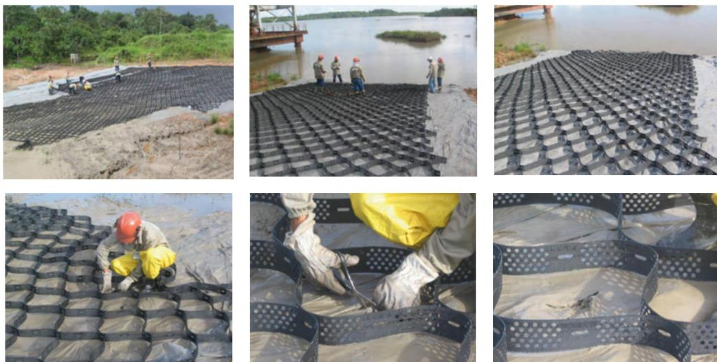
As Figuras 7 a 12. Instalação das geocélulas no manguezal: na expansão e ancoragem firme das seções de geocélula nos taludes e posterior união das diversas seções, através de grampos, para a manutenção da integridade da instalação durante as operações de preenchimento com sedimentos e vegetação nativa.
