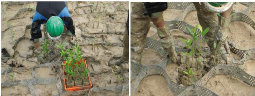
Figuras 13 e 14. Plantio de mudas de *Laguncularia racemosa* em sistema de confinamento celular (geocélulas)
