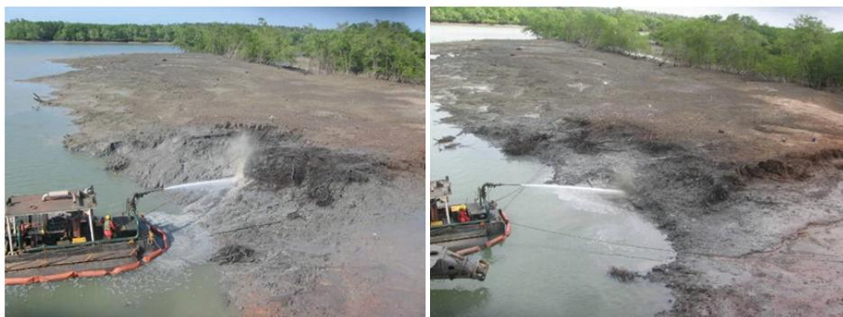
Figuras 4 e 5. Dragagem superficial da área para retirada de troncos e tocos e posterior recobrimento com geotêxtil e sistema de confinamento celular.
