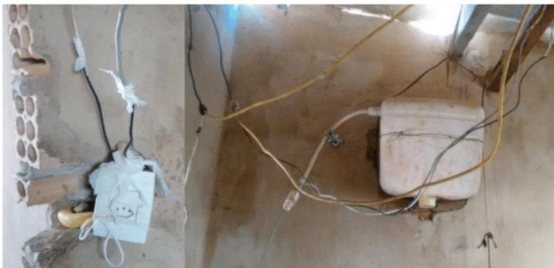
Figura 5 – Fiação exposta, alto número de emendas
