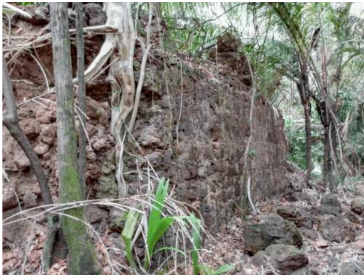
Figura 7 - Ruínas da Ermida de Nossa Senhora da Guia
