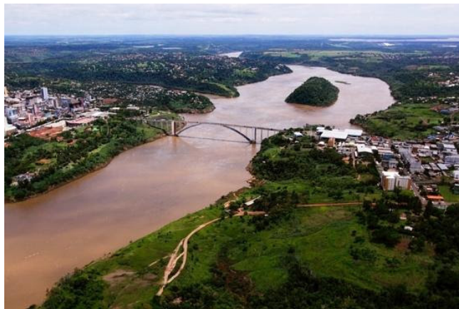
Imagem 1 – Vista aérea da Ponte Internacional da Amizade – Paraguai (lado esquerdo) e Brasil (lado direito).
