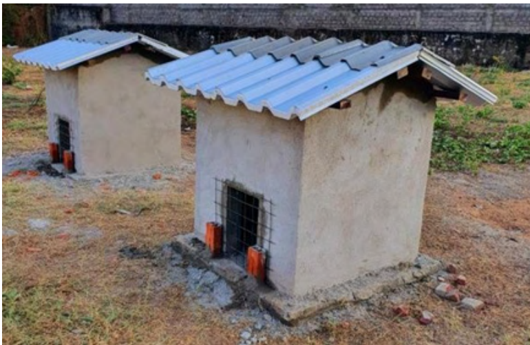
Figura 4: Protótipos com a execução completa.
