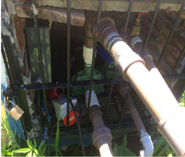
Figura 16 – Bomba centrífuga.
