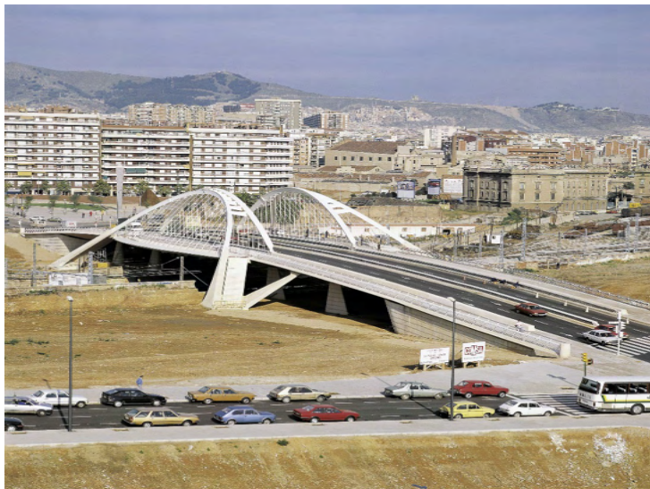
Figura 1- Ponte Bach de Roda, Barcelona, 1987
