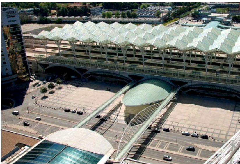
Figura 2 Estação Oriente, Lisboa, 1998. http://papodearquitectas.blogspot.com.br/2013/05/estacao-do-oriente-calatrava.html .
