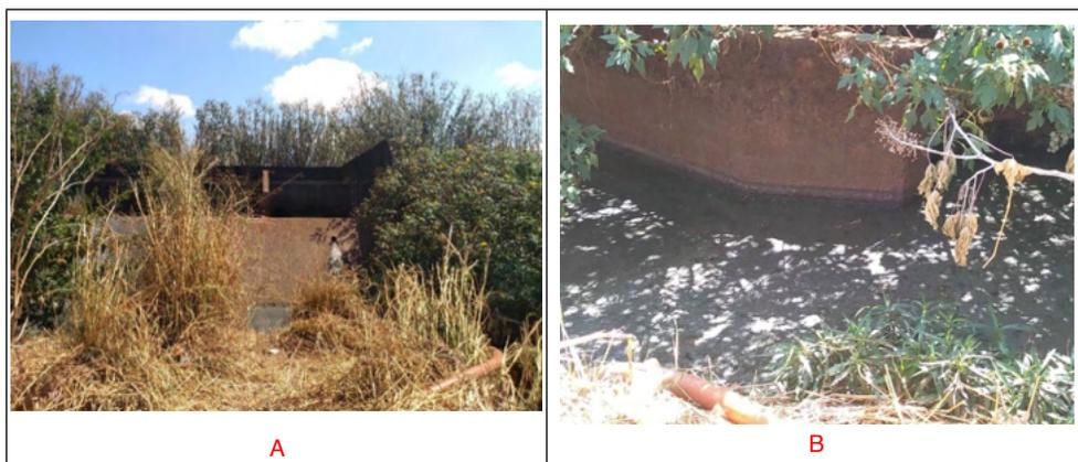
Figura 3 – (A) Condições do 1º bolsão de infiltração / contenção do sistema de drenagem pluvial; (B) Características da água do mesmo bolsão: cor preta e textura de lodo.
