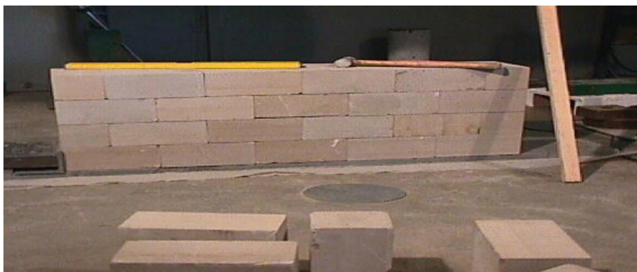
Figura 5: Muro de blocos de pedra
