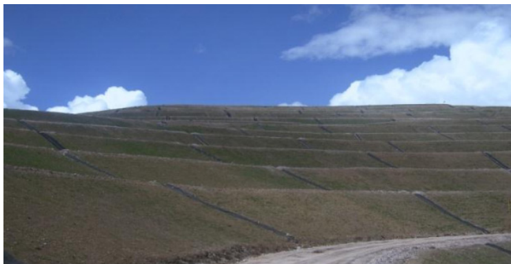
Figura 7. Vista da Pilha de Estéril em processo de restauração, com canais com uso de geotêxtil.
