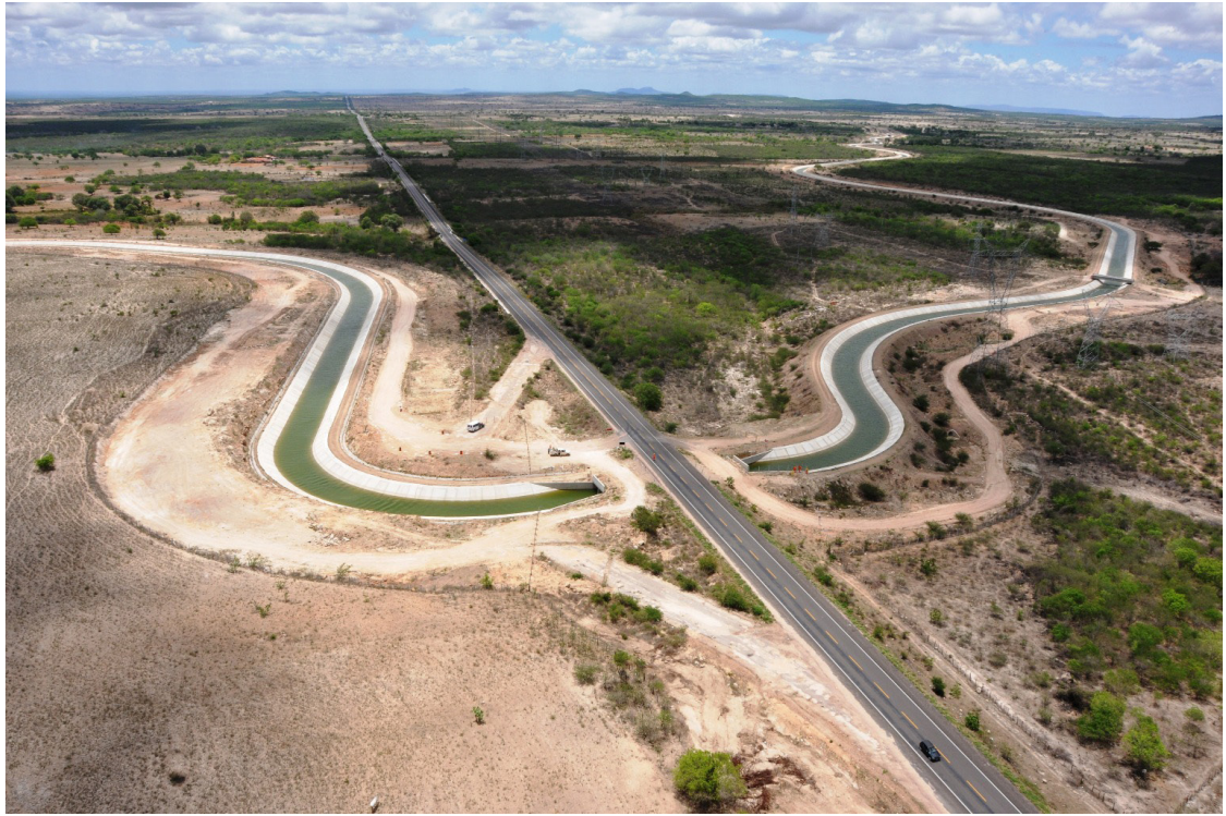
Figura 2 – Vista panorâmica do Canal do Sertão Alagoano
