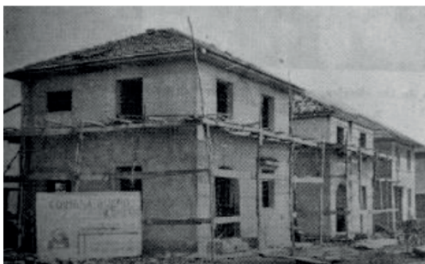
Figura 05: Conjunto de casas-Tipo para funcionários em construção, situadas à Rua 07.
