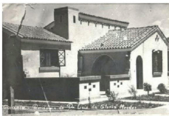
Figura 10: Residência em estilo misiones do Dr. Luiz da Glória Mendes, à Rua 3 esquina com Rua 23, Centro. Fonte: SEPLAN de Goiânia.
