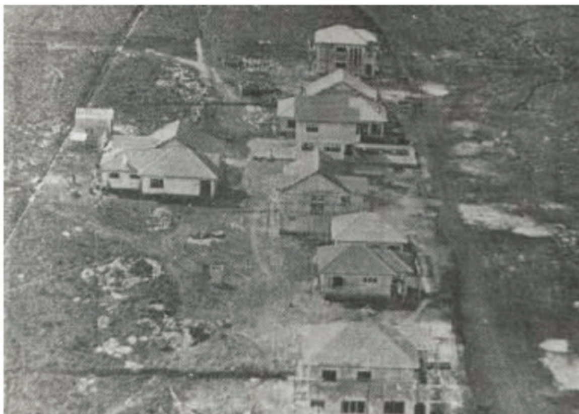
Figura 04: Casas-Tipo Especiais em fase de finalização (1935).
