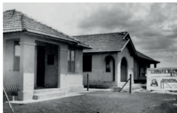
Figura 06: Casas-Tipo Funcionários em fase de acabamento.
