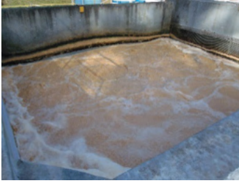
Figura 1. Aspecto dos reatores MBBR monitorados e efluente clarificado após o decantador secundário.
