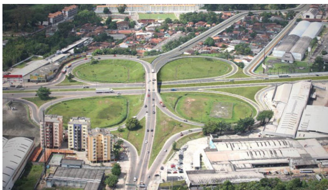
Figura 8. Elevado “Mário Covas”, também conhecido como “Viaduto do Coqueiro”.
