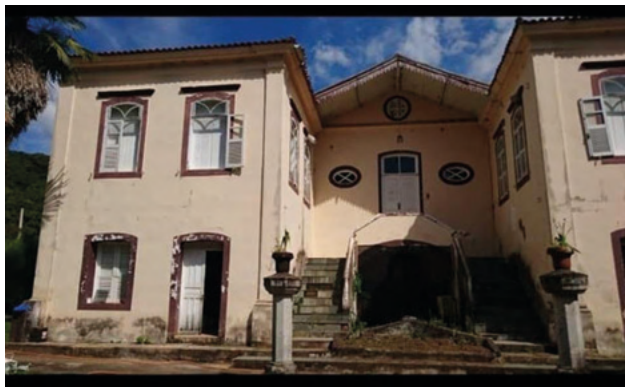
Figura 11 - Casarão antes da reforma (fachada)
