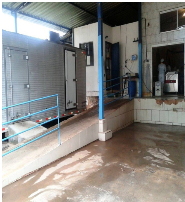
Figura 2- Rampa para acesso à câmara fria
