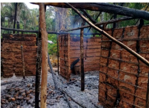
Foto 4 – Parte interna da casa Fonte: CPT, 2018
