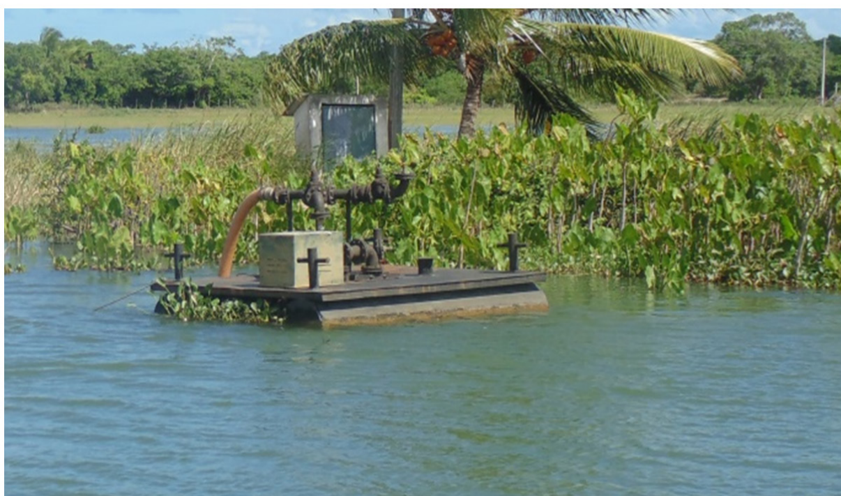
Figura 3: Bomba de captação de água para consumo operada pela companhia estadual de saneamento do estado de Sergipe, para abastecer o povoado Saramém.
