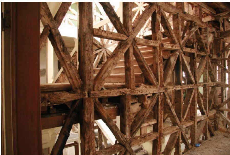
Figura 4. Técnica construtiva gaiola de pombalina.
