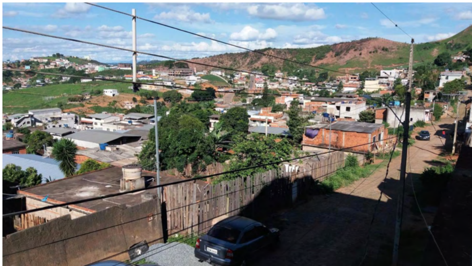
Figura 6: Vista do bairro Nova Viçosa a partir do segundo pavimento de uma casa autoconstruída.
