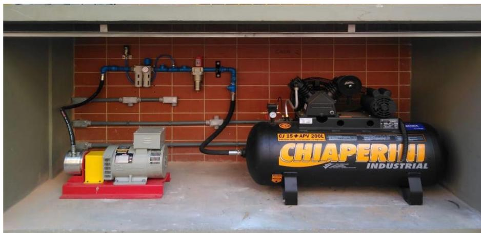
Figura 3. Casa de Compressão e Geração: compressor, reservatório, turbina, alternador elétrico, sistema pneumático de controle, válvula elétrica, válvula, registro, regulador e lubrificador.
