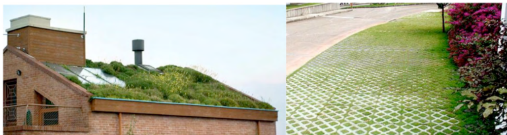
Figura 30 – Cobertura verde e placas fotovoltaicas no telhado de uma residência; piso permeável utilizado na calçada pública.
