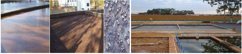
Figura 15 - Leito de Drenagem em escala real na ETA de Guaira – SP.
