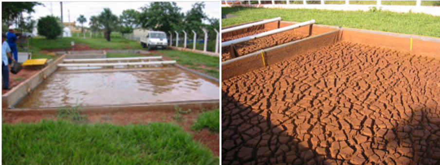
Figura 12 - Leito de drenagem em escala real na ETA Cardoso – SP.
