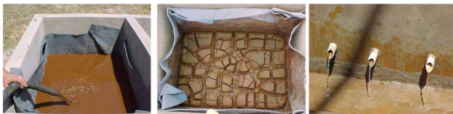
Figura 11 - Fotografias ilustrativas do leito de drenagem piloto na ETA Rio Claro.
