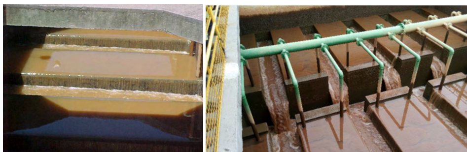
Figura 3 – Resíduos gerados nos filtros de ETAs.
