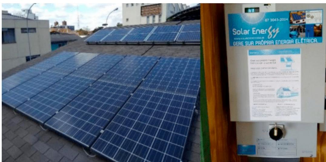
**Figura 4 e 5:** Painéis FV e inversor do Escritório Verde
