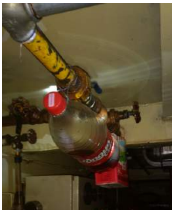
Figura 2 – Solução improvisada para coleta de óleo.
