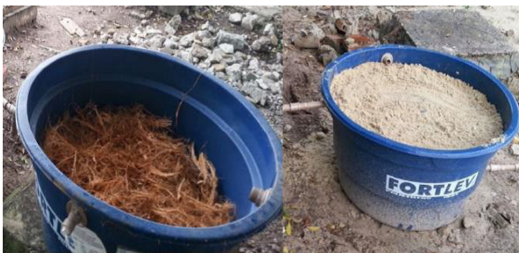
Figura 1 – Etapa da montagem do sistema com as camadas de brita, fibra de coco e areia.
