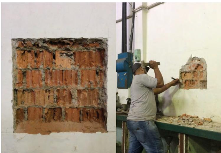
Figura 3.4 – Processo de abertura da janela de inspeção
