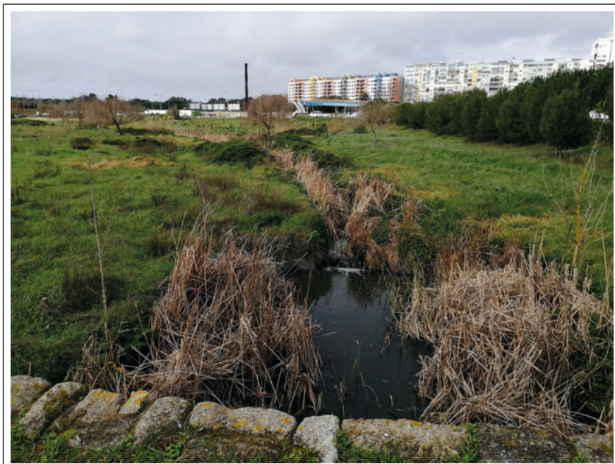
Figura 18: Bacia de retenção no trecho da freguesia da Cova da Piedade. Local que inicia a canalização das águas retidas.
