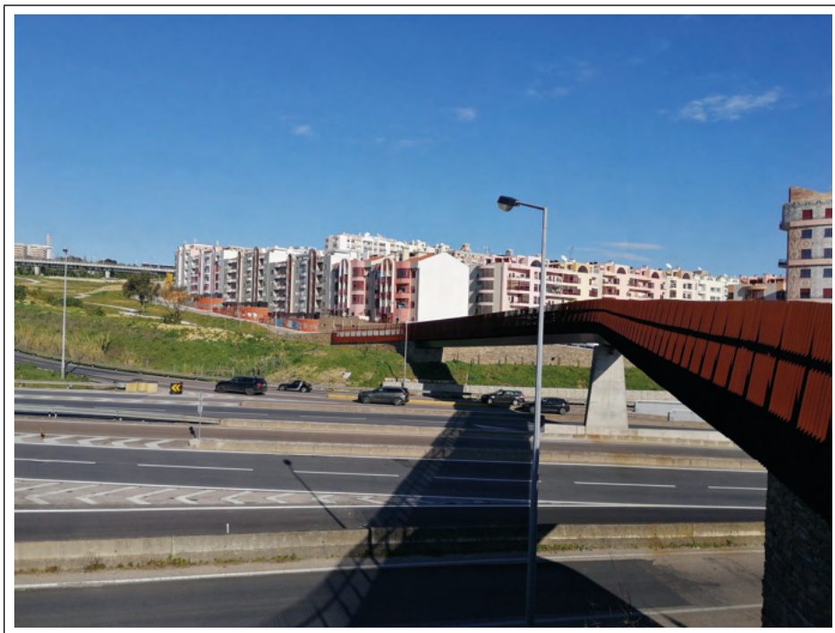
Figura 15: Vista da passarela que atravessa a via expressa A2 e conecta o Parque da Paz com a freguesia do Pragal.
