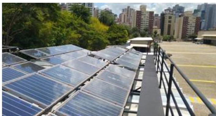
Figura 6- Planta de aquecimento solar composta por 44m<sup>2</sup> de área coletora
