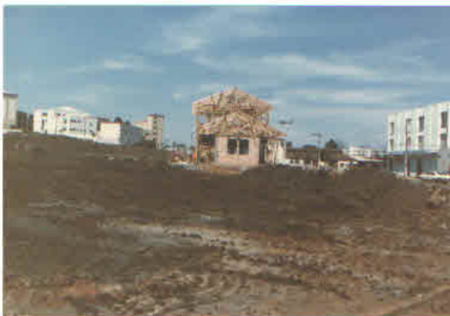
Figura 4. A Construção da Réplica da Estação Ferroviária Rio Caçador.
