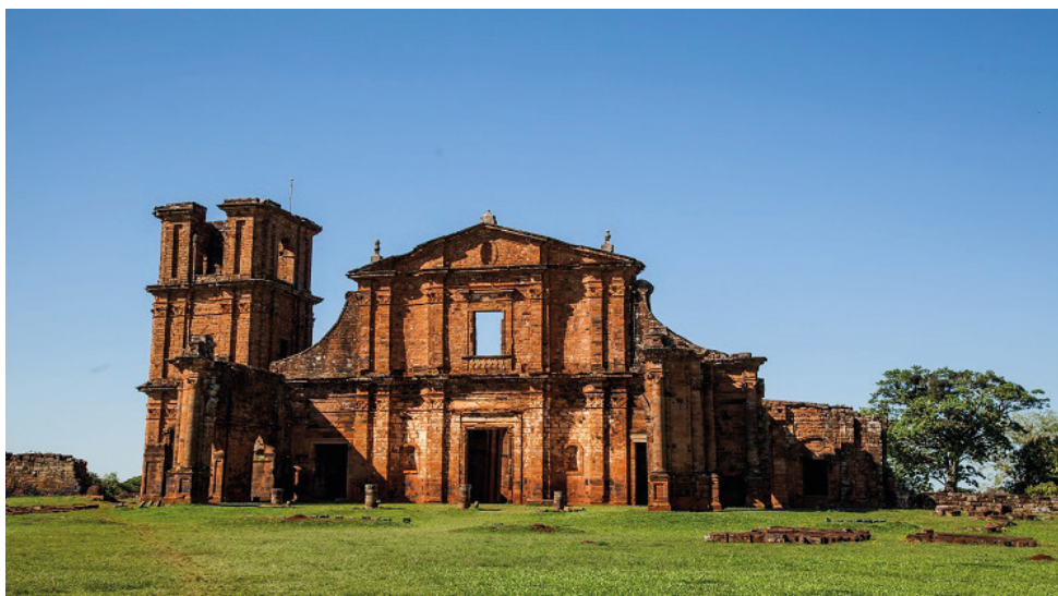
Figura 5 - Ruínas da Igreja de São Miguel Arcanjo
