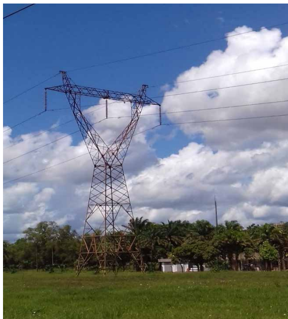
Figura 1 - Torre de Linha de Transmissão.
