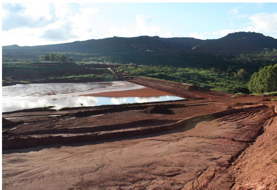
Figura 3: Barragem de rejeitos da extração de minério de ferro
