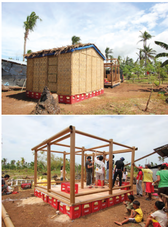
Figuras 6 e 7 – Abrigo temporário nas Filipinas e processo construtivo (SHIGERU BAN ARCHITECTS, 2018b, online )
