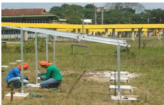
**Figura 11** - Montagem das estruturas.
