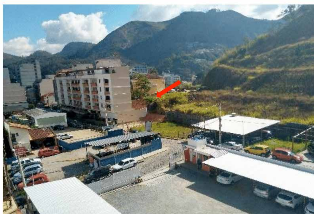
Figura 3: (a) foto no ano de 2014 com parte do prédio destruído pelo movimento de massa e gabiões na encosta; (b) prédio reconstruído em 2018.
