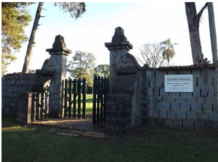
Figura 02 - Portal de entrada do Cemitério.
