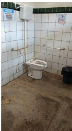
Fig. 18: Vaso e barras inadequadas
