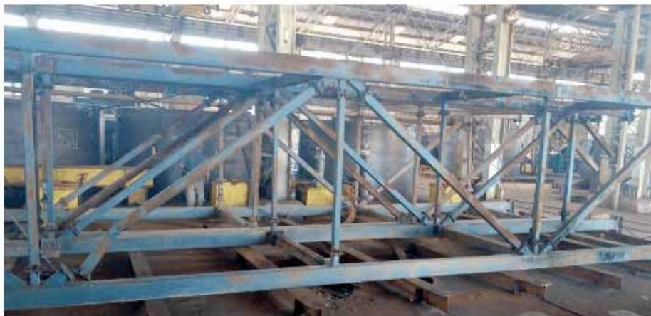
Figura 3 – Vista de parte da estrutura, com diversas regiões em avançado estado de corrosão.
