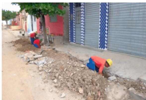
Figura 2 - Visita às obras de instalação da rede coletora na Rua Nossa Senhora do Rosário no Bairro Pedra Velha
