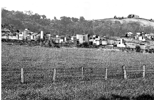
Figura 12: Inserção de condomínios residenciais fechados na área rural.
