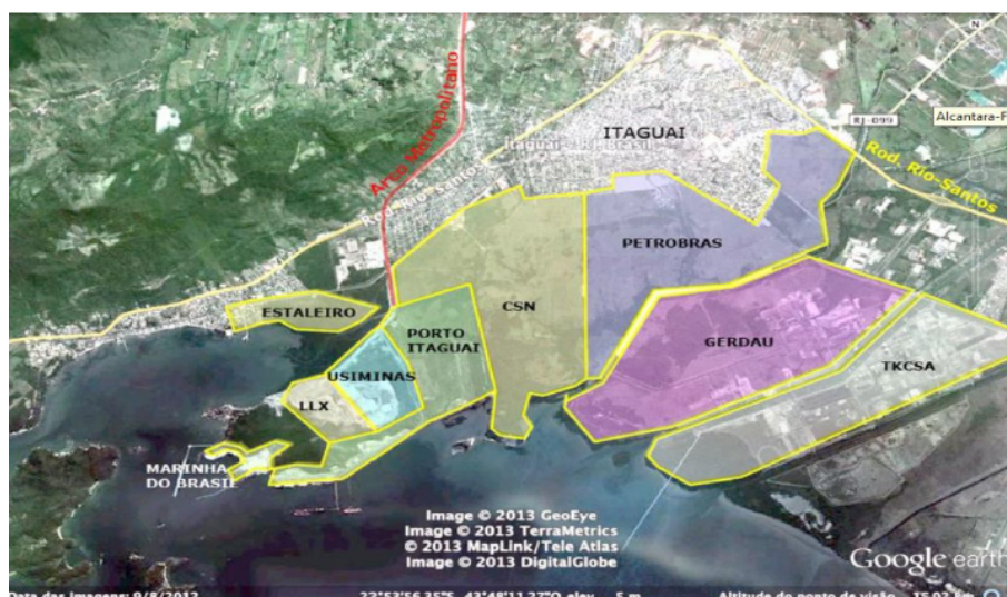
Figura 01. Complexo Portuário, Estaleiro Naval, Petrobrás, Gerdau e TKCSA Fonte: Alcântara (2013).
