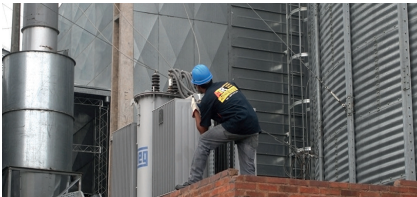
Foto 3: Pruebas con pinza amperimétrica
