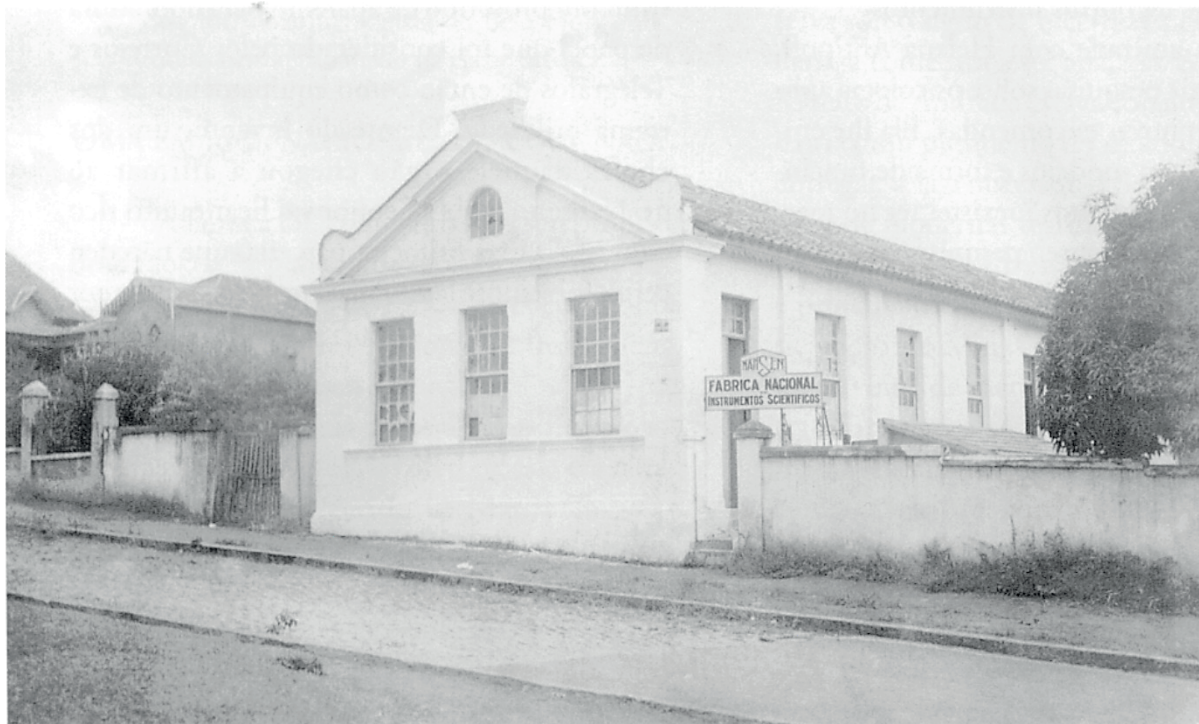
Figura 3 – 2ª Sede – Av. do Contorno, 4766 – Bairro Serra
