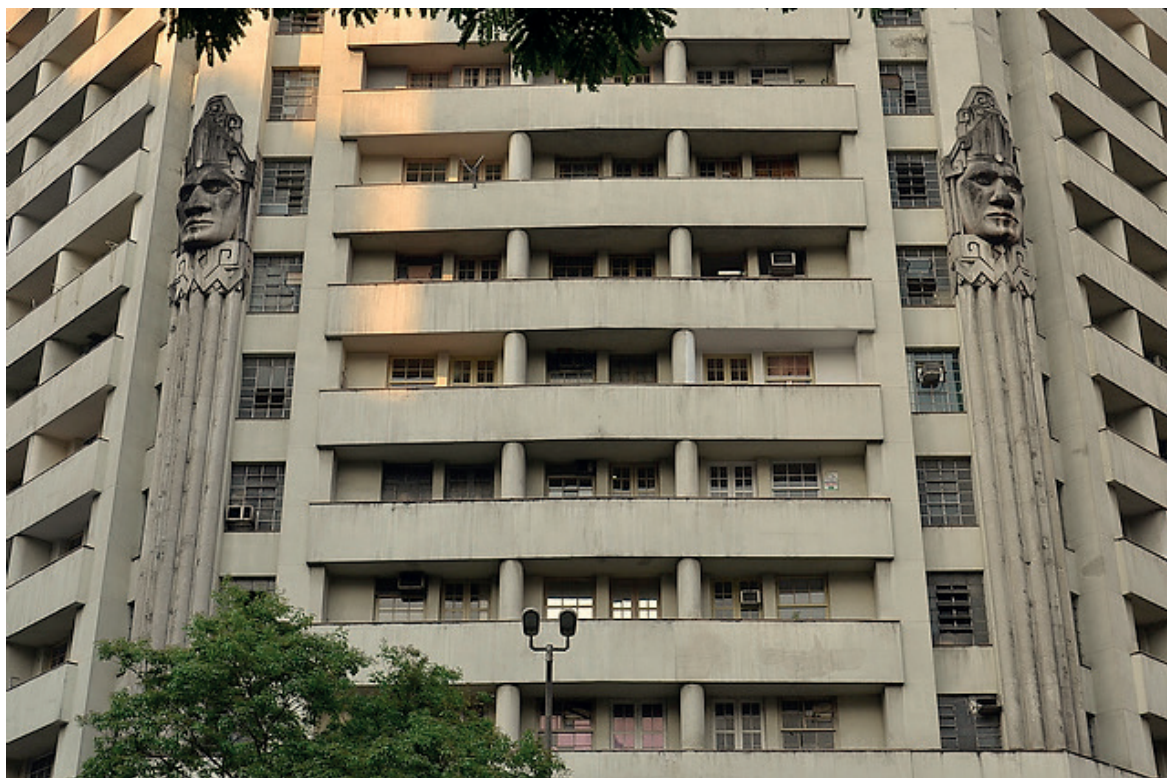
Figura 1 – Edifício Acaiaca (detalhe da fachada)
