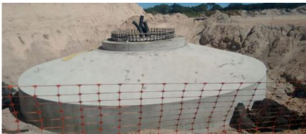
Figura 4 – Sapata concretada (Autores. (2016)).
