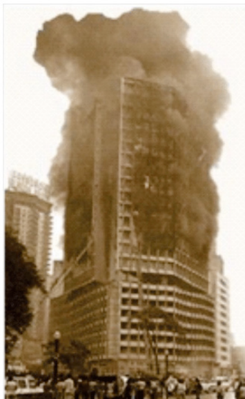
Figura 2 – Incêndio no edifício Andraus.
